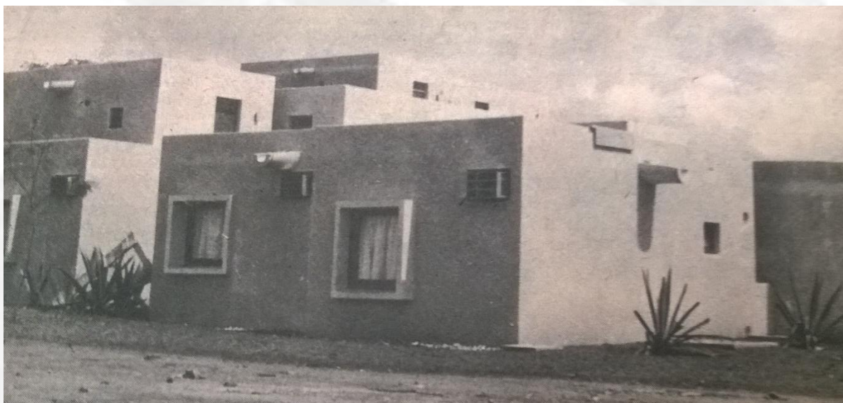
Photo n°3 : Vue d'un côté de l'hôtel Les frontières d'Odienné
