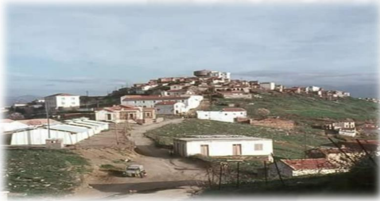
Fig.2 Vue de l'ensemble des villages après l'indépendance (Source : Archive Ath yenni)
